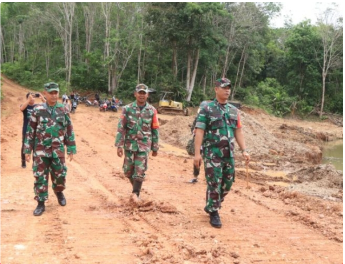
Dandim 1006/Banjar Letkol Inf Imam Muchtarom Tinjau Sasaran Jembatan
