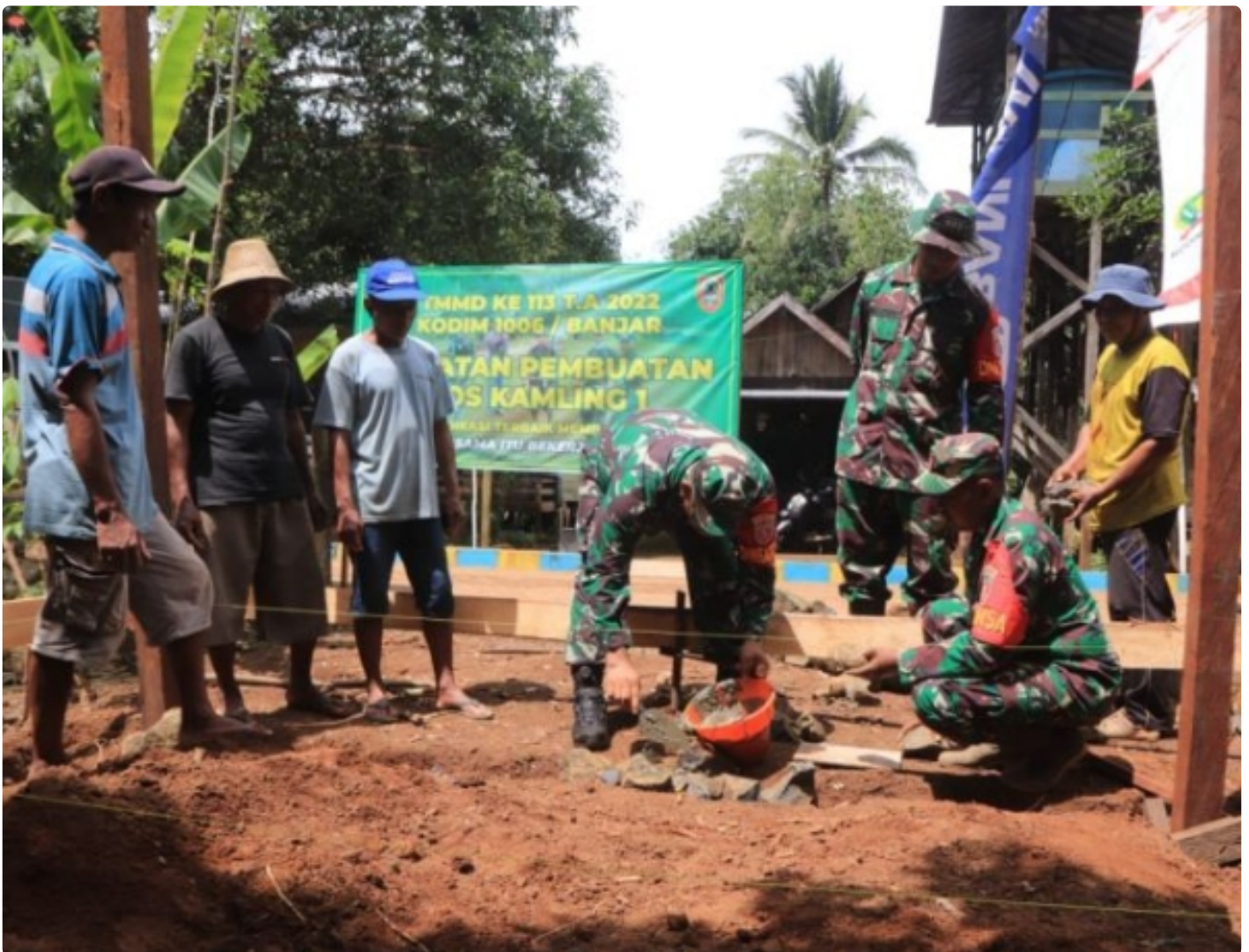
Peletakan Batu Pertama Pembangunan Pos Kamling Oleh Dansatgas TMMD ke-113 Kodim 1006/Banjar
