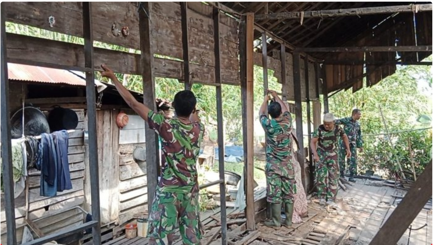
Hari ke Dua Bantuan Rehab RTLH Kodim 1006/Bjr, Bangun Tiang dan Rangka Rumah
