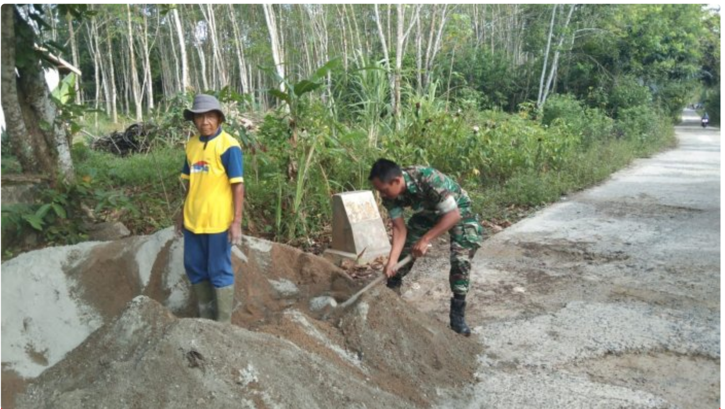
Babinsa Bantu Gotong Royong Pengecoran Jalan
