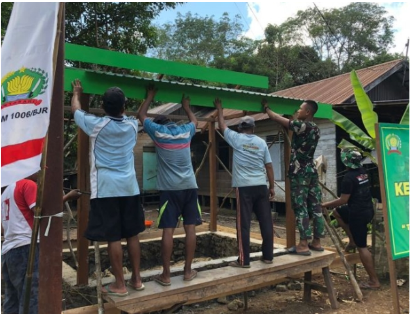
Pemasangan Atap Poskamling sasaran TMMMD ke-113 Kodim 1006/Banjar
