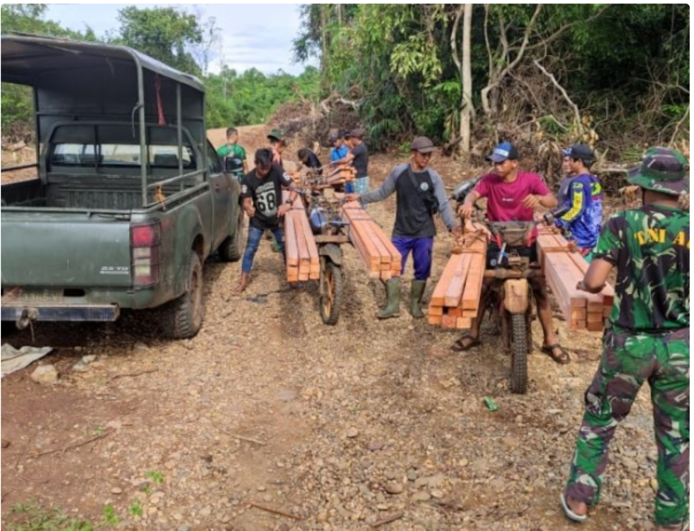
Warga Bantu Bawa Balok Kayu Untuk Jembatan
