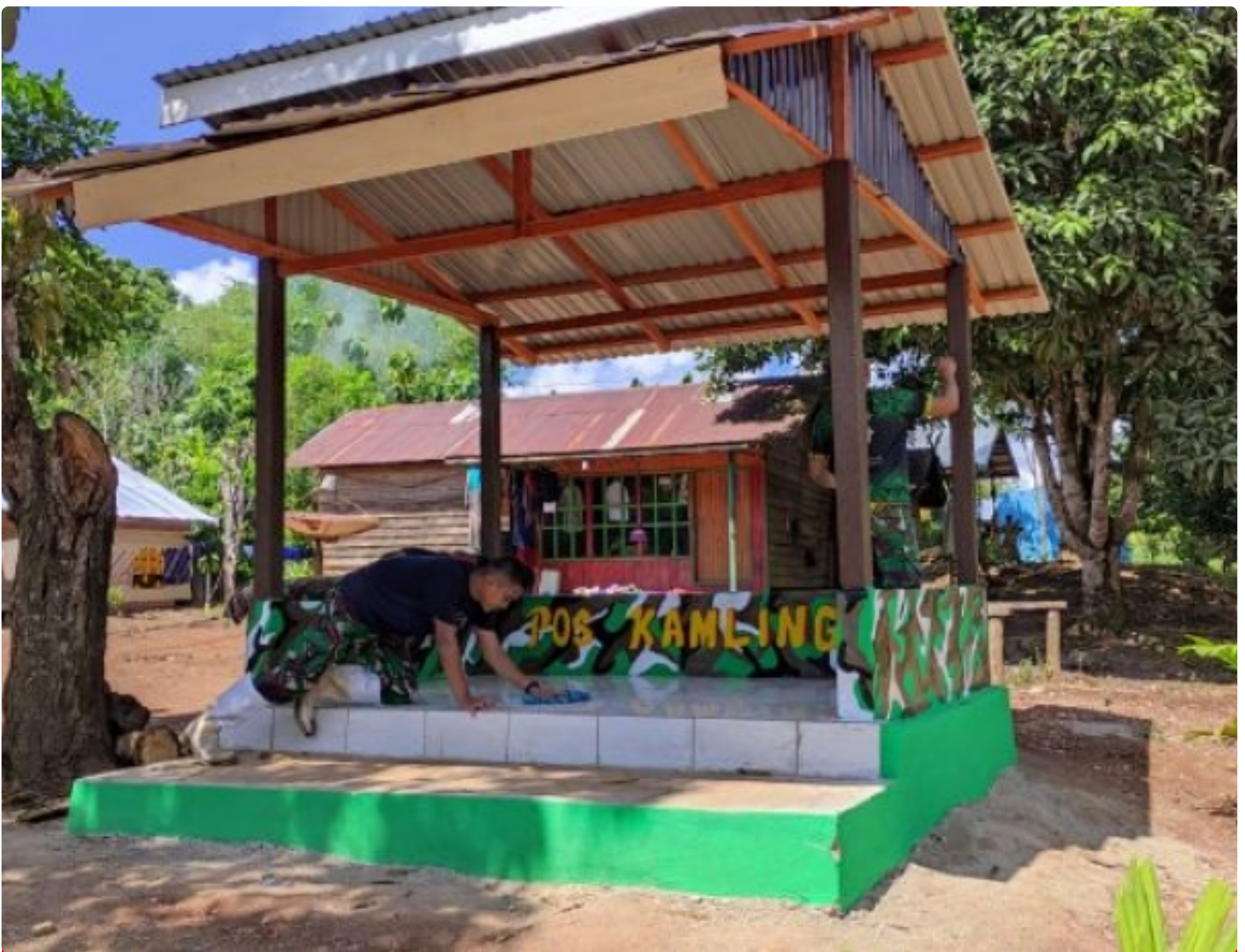
Anggota Satgas TMMD ke-113 Kodim 1006/Banjar Finishing Pembangunan Pos Kamling
